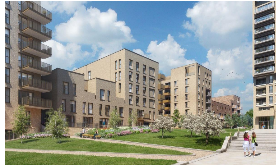
Vista del complesso dal cortile interno
